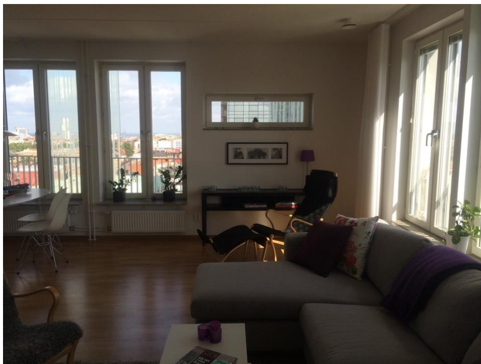
Figur 3.6 Interiör från modern lägenhet där fönster utförts som kopplade (1+2) med mellanglaspersiennerna i östligt väderstreck (till höger i bild) och utan persiennerna åt norr (fönstren till vänster i bild). (Foto Helena Bülow-Hübe)
