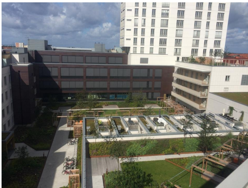
Figur 3.4 Exempel på olika slags solavskärmning. Den bruna fasaden är försedd med utvändig mörk screenväv som är nerfälld i bilden. Till höger i bild finns balkonger/loftgångar som skuggar fönstren. Det vita uppstickande huset är försett med mellanglaspersiennier, och man kan tydligt se vilka fönster som har dem nerfällda. (Foto: Helena Bülow-Hübe)
